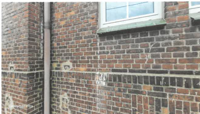
Fot. 7. Fragment elewacji, na którym widoczny jest stan cegieł; parapety wykonane z zielonego klinkieru
