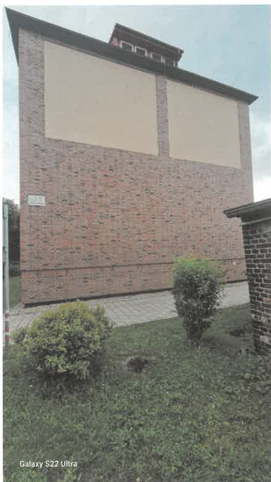
Fot. 3. Kamienica przy ul. Jastrzębskiej 7. Bok; widoczne podbitki dachowe
