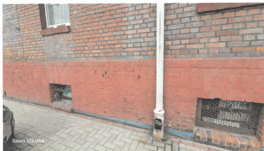
Fot. 9. Fragment elewacji z przemalowanymi cegłami
