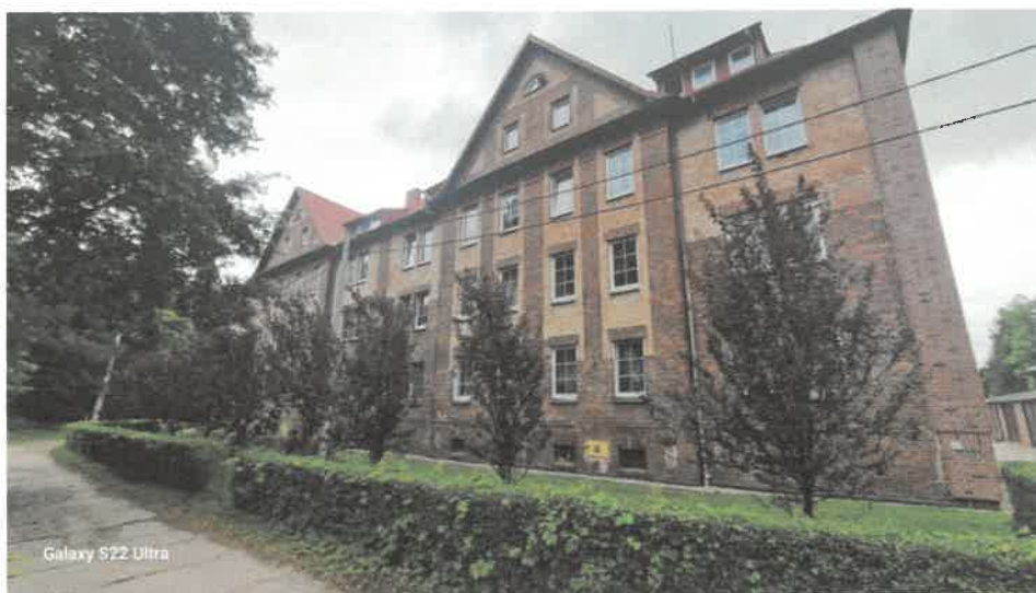
Fot. 1. Kamienica przy ul. Jastrzębskiej 7. Front
