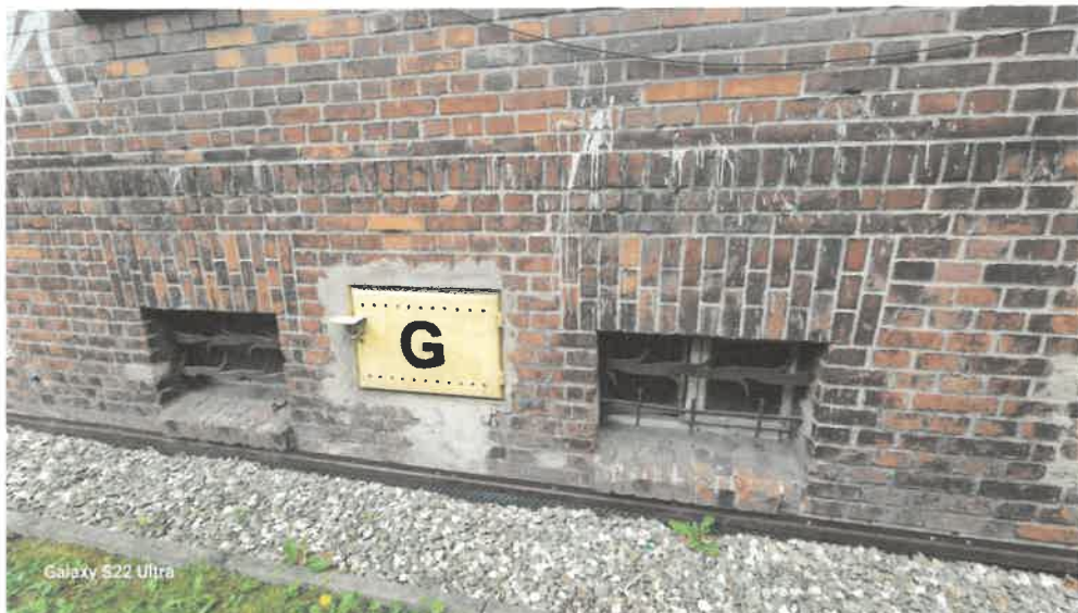
Fot. 12. Widoczna skrzynka gazowa
